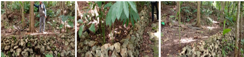
Gambar E-61 Sengkedan, berupa tumpukan batu batu gamping yang digunakan untuk menahan erosi tanah
